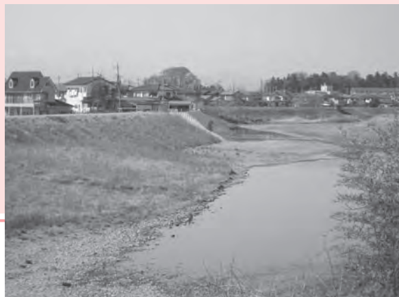
着実に進む黒川護岸整備
